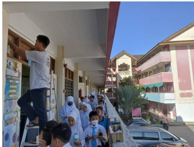
Rajah 3.2.4 a: Pemasangan Client di Blok B
