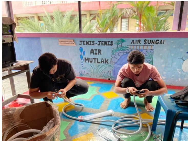
Rajah 3.2.4 c: Penyediaan kabel Access Point
